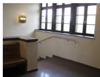
Aufzug gegenüber der Treppe
