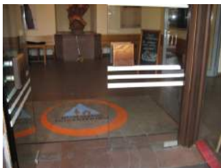
Windfangtür Blick von aussen
