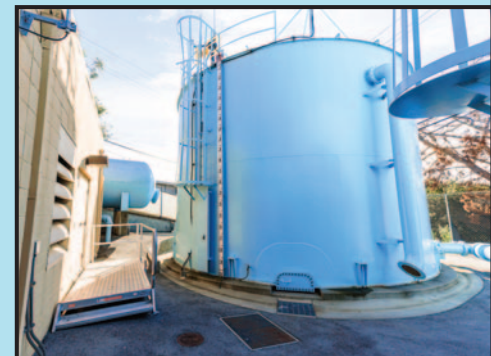
Sitio del tanque de almacenamiento de agua Buckland.
