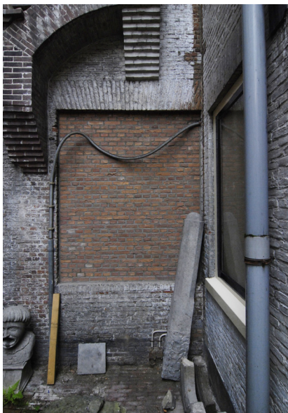
Raamopeningen zijn echter mooi bewaard gebleven in een origineel omliggend metselwerk. Behoud daarvan verdient de voorkeur.
