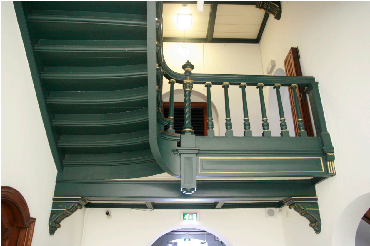
Foto van de onderzijde van de Joristrap in de huidige situatie
