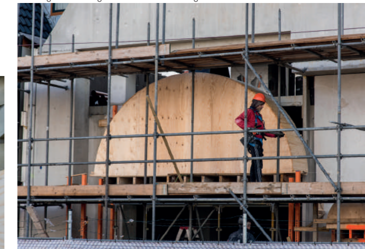
Plaatsing van de boogconstructie in de achtergevel
