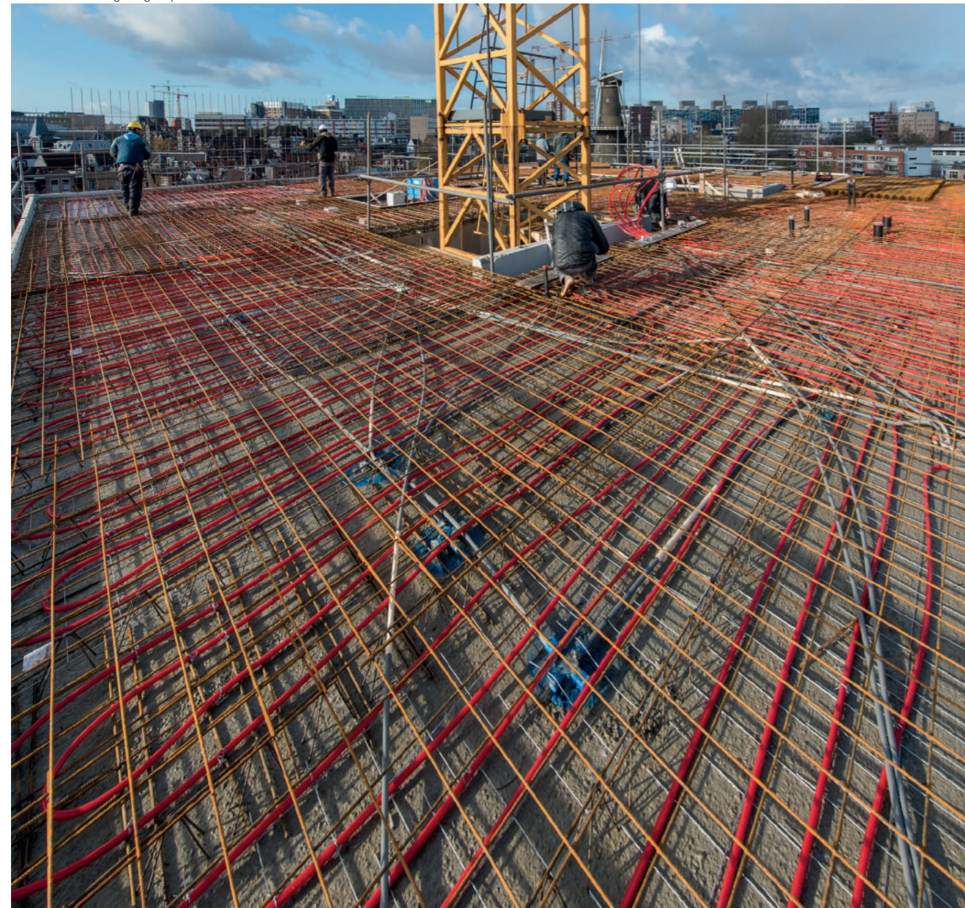
Laatste fase richting hoogste punt van de nieuwbouw
