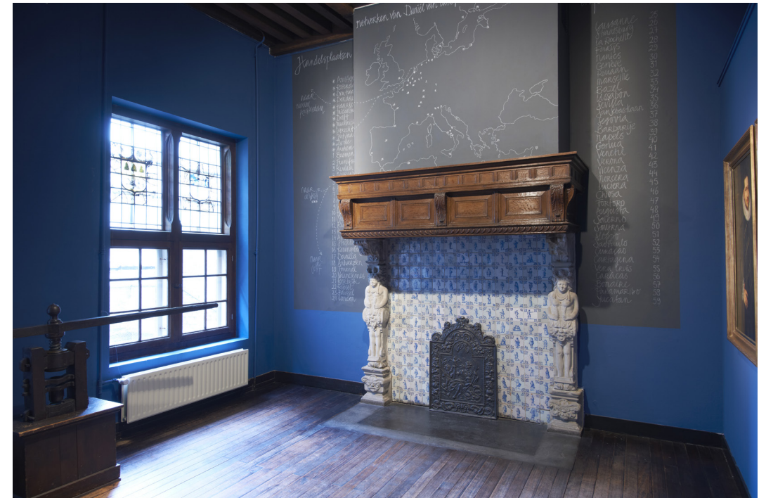
Stempelkamer situatie 2016 met een replicakozijn uit 1986. Tijdens de restauratie keert hier het zestiende-eeuwse kruiskozijn terug.
