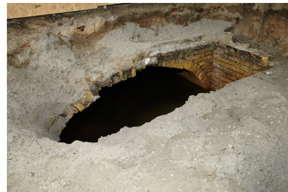
Ontdekking waterkelder achterplaats
