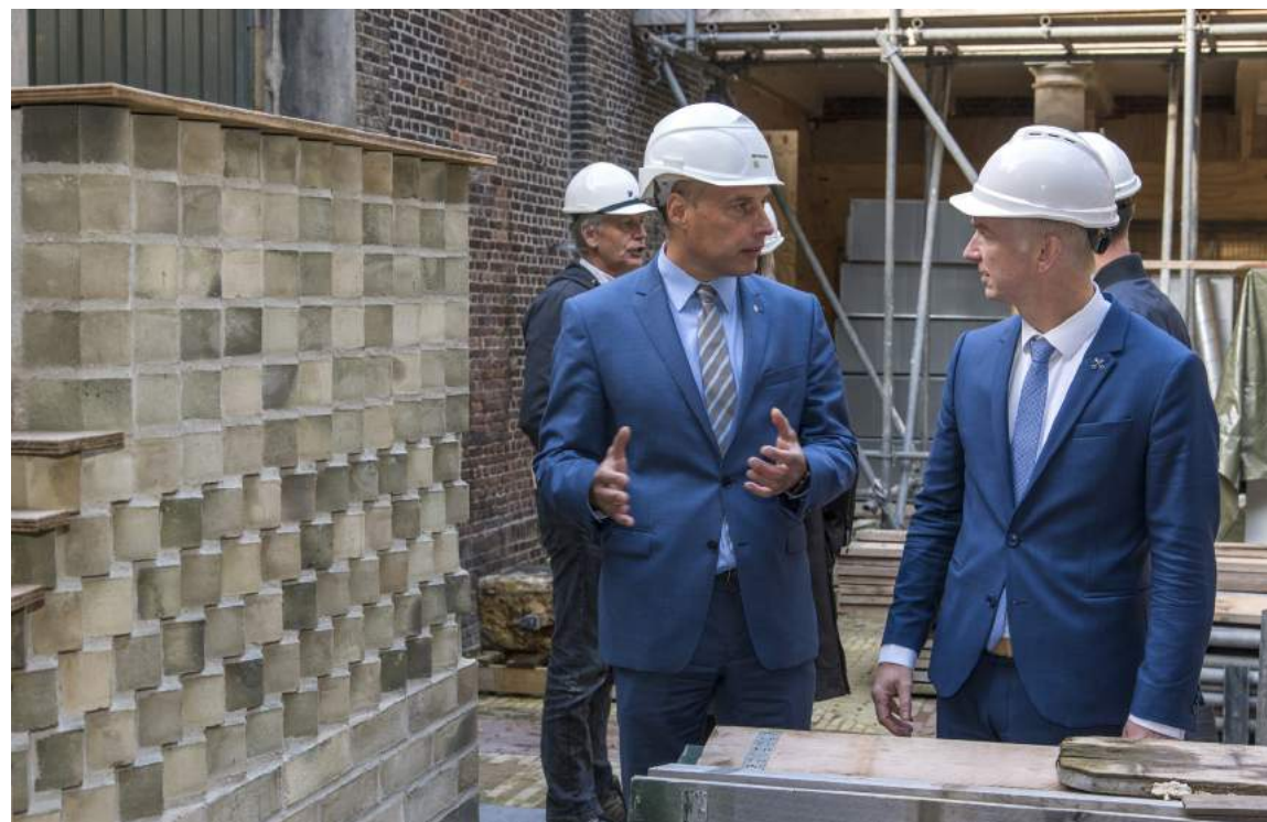
Anton Spaan, hoofdaannemer van bouwcombinatie Nieuw Laecken vertelt wethouder Robert Strijk over het 'muizentand' metselverband dat zal worden toegepast bij de nieuwe achtergevel aan de Lammermarkt.
