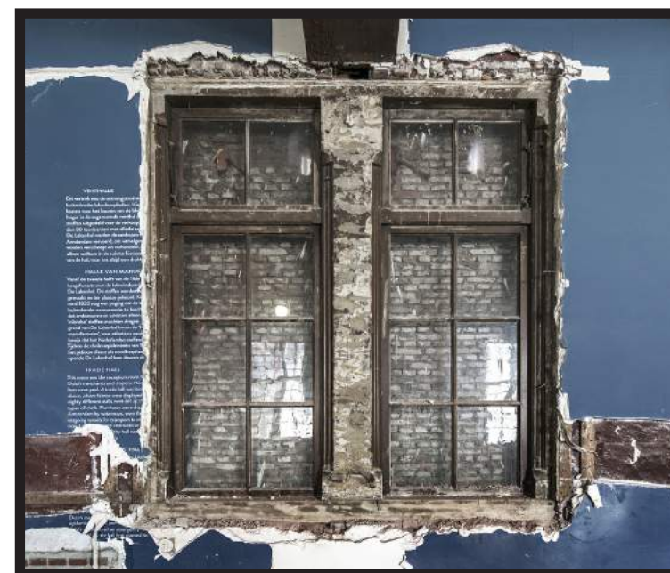
Bij het afpellen van tijdlagen komen verborgen elementen als dit raam in de oude 17e eeuwse Laecken-Halle tevoorschijn.
