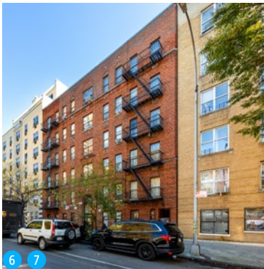
2083 Mohegan Ave & 2082 Crotona Pkwy
