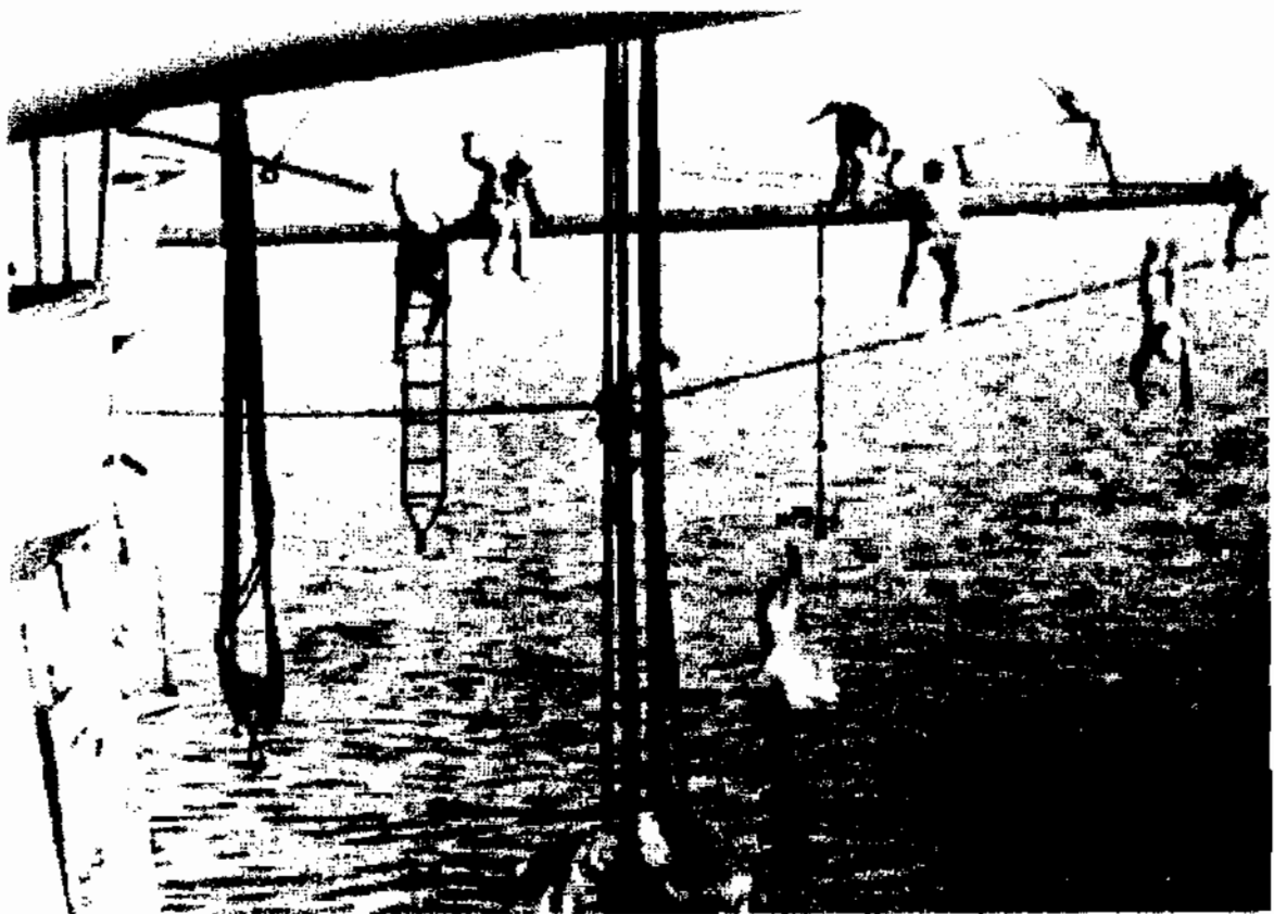
رژمنای پوتمکین: ژیمناستیک
