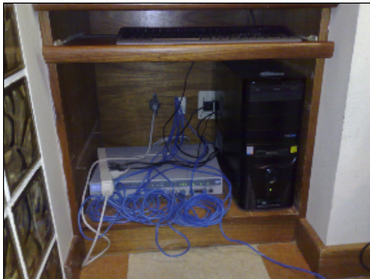
Figura 11 – Switch da Clínica Fonte: Oncoterápica (2008).
