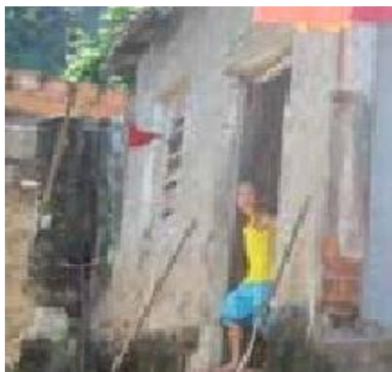
Figura 5.1 – Barraco em área de risco
