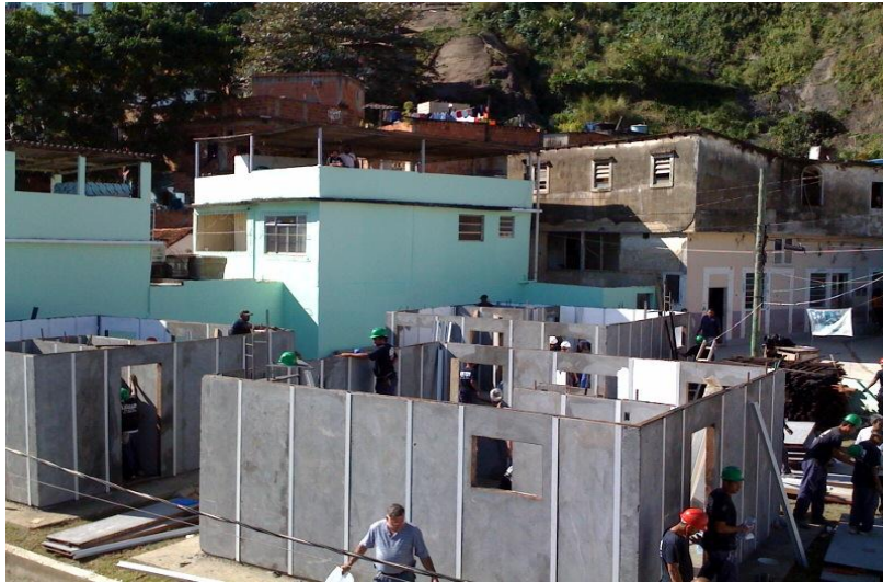
Figura 5.2 – Construção das casas – mutirão de moradores do morro
