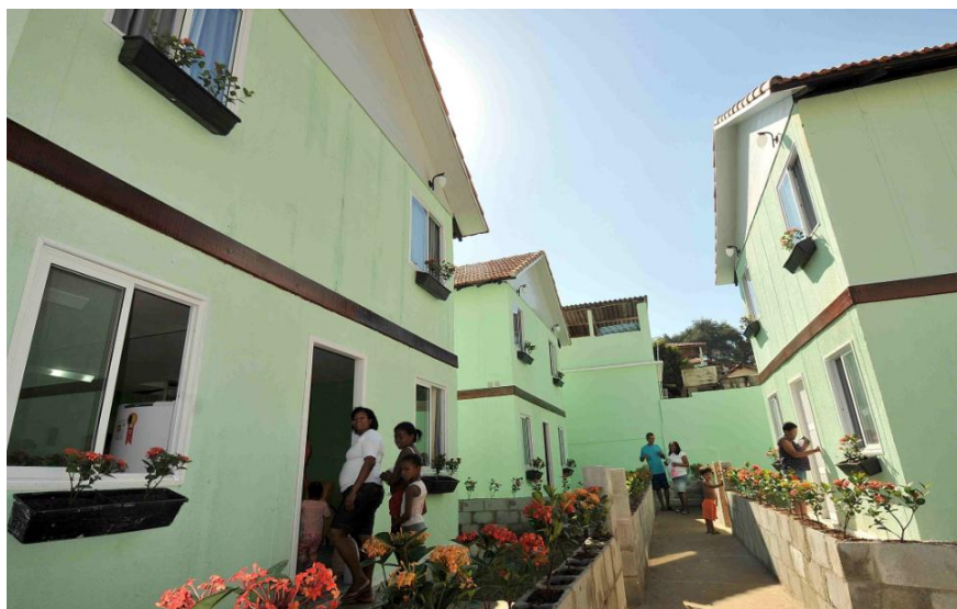
Figura 5.6 – Vila de casas no morro da providência - projeto cimento social
