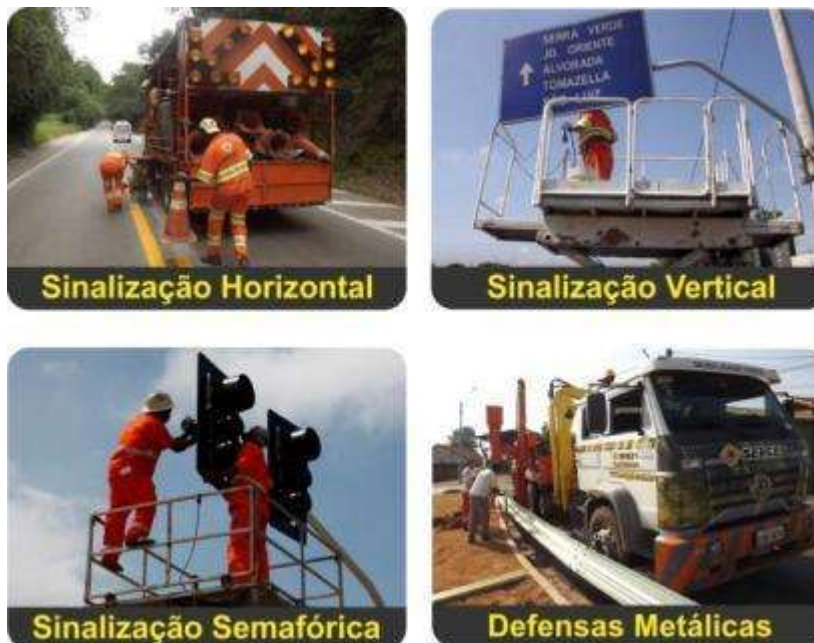
Figura 22 - Principais serviços de Sinalização e Segurança Viária
