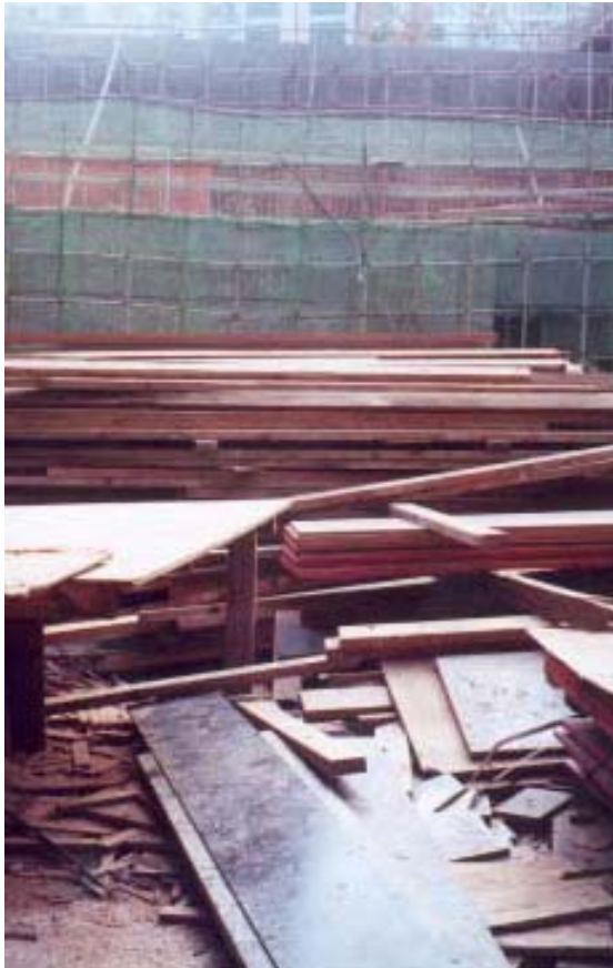
Figura 3.8 - Fôrmas de madeira a ser descartadas
