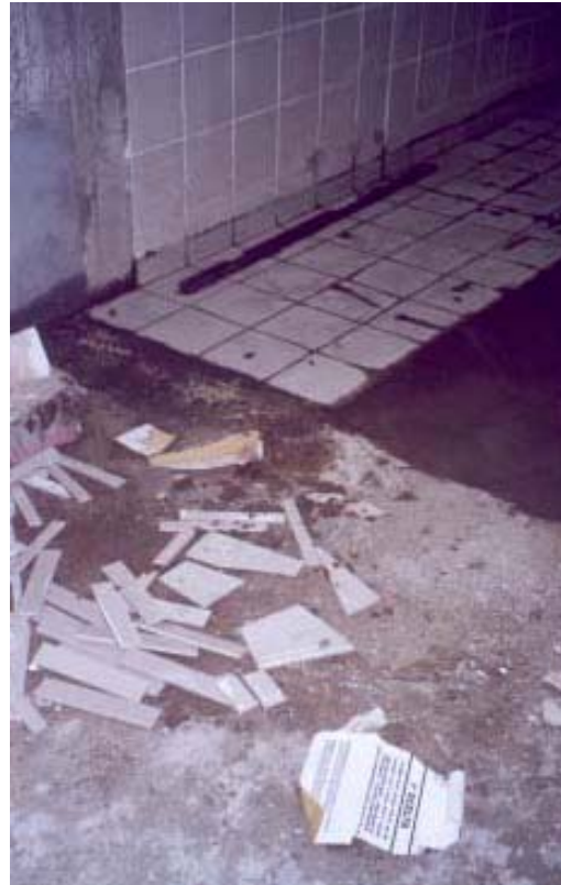
Figura 3.9 - Recortes em peças cerâmicas decorrentes da falta de detalhamento de projetos
