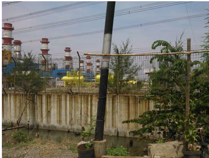
Gambar 2.18 CNG pada PLTGU Tambak Lorok PT Indonesia Power
