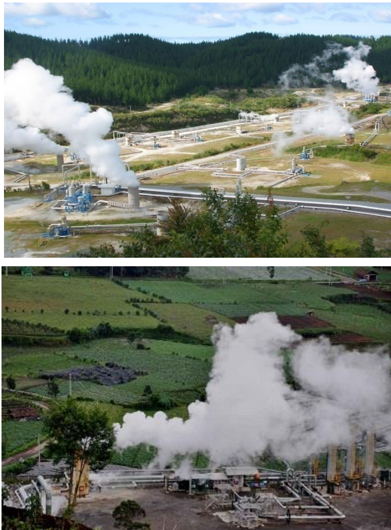
Gambar 2.5 PLTP Baturaden Kabupaten Banyumas dan PLTP Dieng Wonosobo
