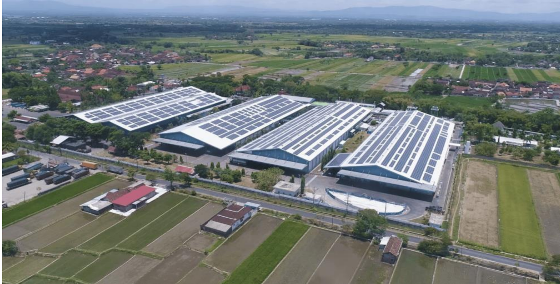
PLTS 2,9 MWp milik Pabrik Aqua Danone di Klaten, Jawa Tengah. Sumber Gambar: EBTKE
