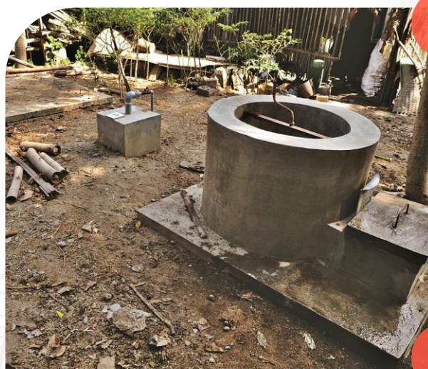
Komponen Bangunan Reaktor Biogas Rumah (BIRU)
