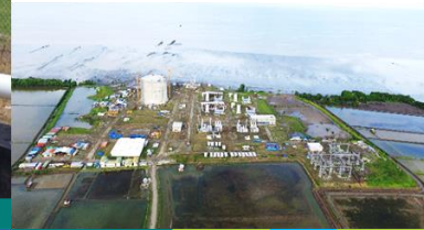
Keera Metering Station (KMS) - LNG Plant
