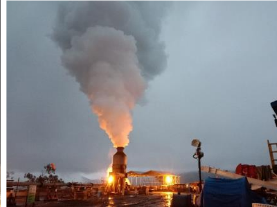
Ijen Geothermal 2 x 55 MW
