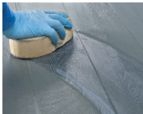
Czyszczenie i profilowanie fug przy użyciu gąbki celulozowej
