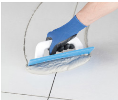
Spoinowanie płytek przy pomocy pacy gumowej
