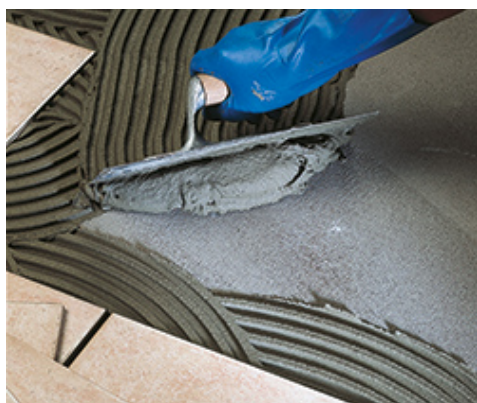
Montaż płytek typu monocottura na podłozie
