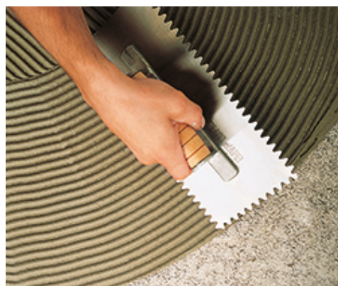
Rozprowadzanie Adesilex P9 Zero w kolorze szarym
