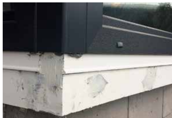
Zdjęcie nr 29 – Miejsce dla montażu podstaw parapetu zewnętrznego (PPZ)
