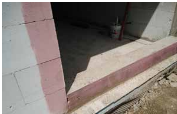
Zdjęcie nr 3 – Przygotowanie otworu – gruntowanie
