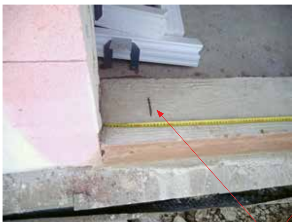
Zdjęcie nr 1 – Pomiar kontrolny otworu, naniesienie osi belek CBM
