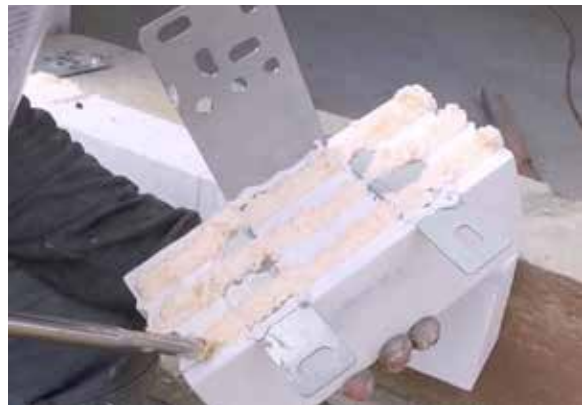
Zdjęcie nr 12 – Nałożenie kleju do styropianu PU
