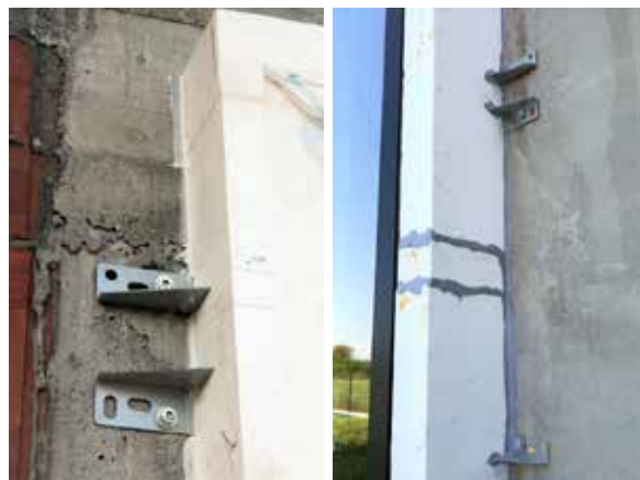
Zdjęcia nr 31; 32 – Szpachlowanie spoin i składań belek CBM uszczelniającym hybrydowym w miejscach gdzie możliwe jest gromadzenie się wody oraz akrylem na łączeniach pozbawionych takiego ryzyka (np. sputkanie deszczem w trakcie wiązania)
