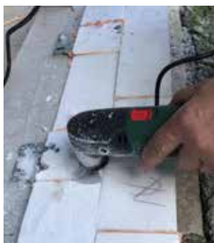
Zdjęcie nr 19 – Szlifowanie za pomocą szlifierki oscylacyjnej
