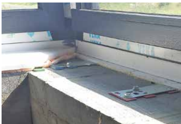
Zdjęcie nr 28 – Montaż parapetów wewnętrznych (PPW)
