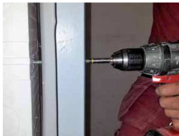
Zdjęcie nr 27 – Wkręcanie śrub ościeżnicowych
