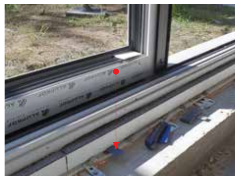
Zdjęcie nr 21 – niezalecane zastosowanie podkładek plastikowych
