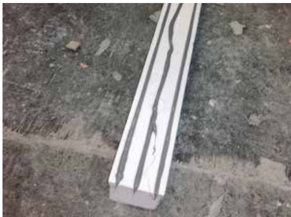
Zdjęcie nr 22 – trzy ścieżki hybrydy na belce BP Połączenie w strefie podprogowej belki BP z belkami CBM
