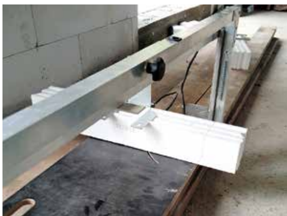
Zdjęcie nr 7 – Docinanie belek CBM struną termiczną
