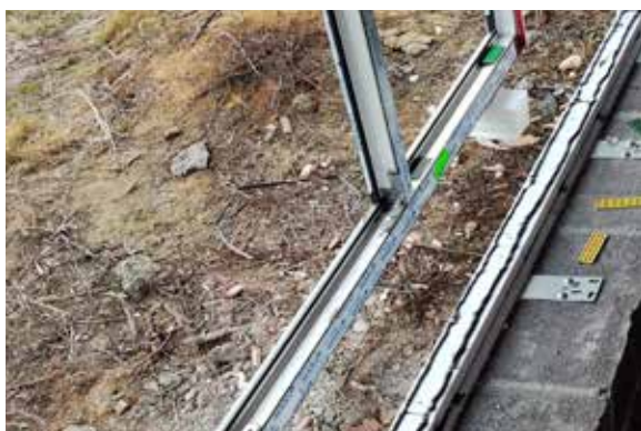
Zdjęcie nr 24 – Nakładanie ramy na belkę BP z belkami CBM
