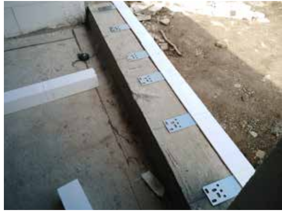
Zdjęcie nr 10 – Próbné ustawienie dociętych belek
