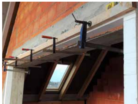
Zdjęcie nr 16 – Użycie ścisków utapia i przyspiesza prace
