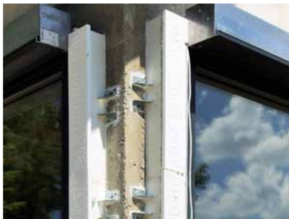
Zdjęcie nr 30 – Zamontowany Węgarek (W)
