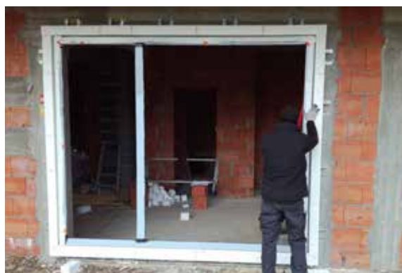
Zdjęcie nr 25 – Stabilizacja ramy klinami przed wierceniem otworów i wkręcaniem śrub ościeżnicowych
