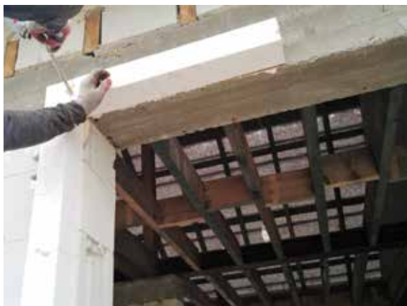
Zdjęcie nr 15 – Montaż górnej linii CBM
