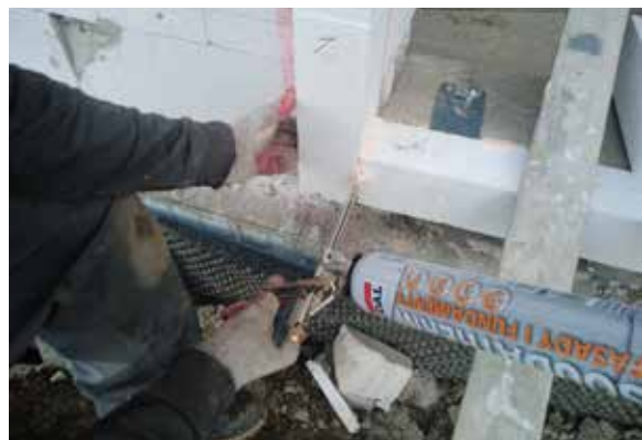
Zdjęcie nr 14 – Montaż bocznej linii CBM
