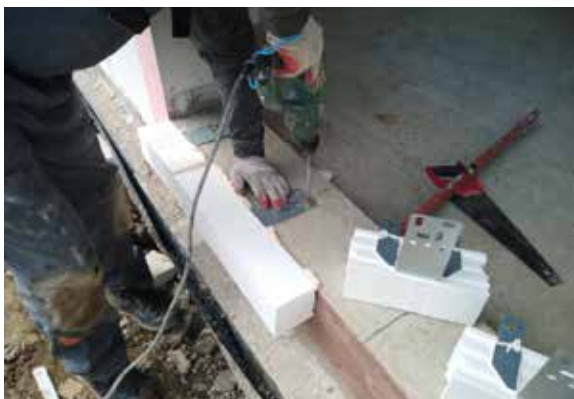
Zdjęcie nr 13 – Montaż dolnej linii CBM
