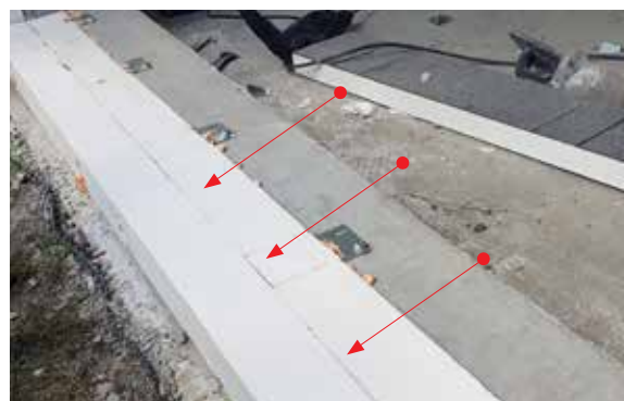
Zdjęcie nr 18 – Przykład podkładu pod okna HST
