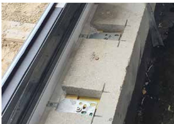
Zdjęcie nr 5 – Nacięcie i wybranie żelbetowego progu. Osadzenie blachy wspornika CBM na wymaganym poziomie
