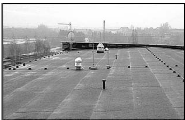
Dach kryty papą
