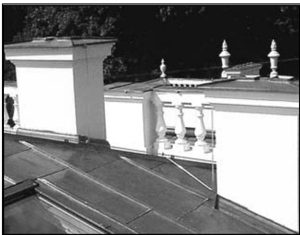
Obiekt zabytkowy dach kryty blachą miedzianą
