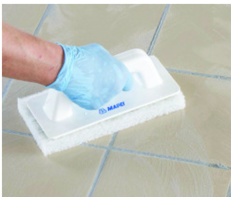
Czyszczenie spoin za pomocą Scotch-Brite®
