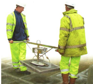
Rys.1. Prawidłowe zdejmowanie płyt z palety
