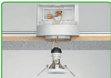
Podłączanie oprawy oświetlenia niskonapięciowego
