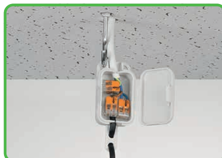
Montaż lamp wiszących w podwieszanym suficie
