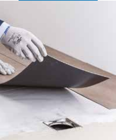
Montaż płytek LVT za pomocą Ultrabond Eco MS 4 LVT w wilgotnym pomieszczeniu
