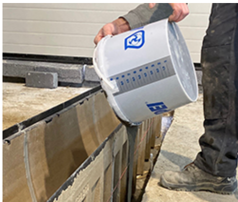
Wlewanie Mapegrout SV Smart do szalunku
