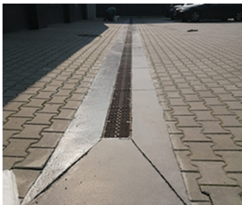
Gotowe odwodnienie osadzone przy użyciu Mapegrout SV Smart
