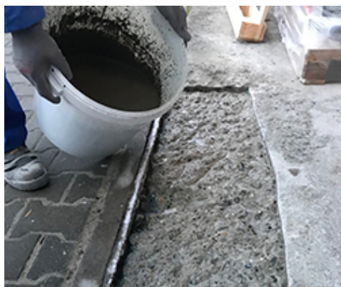
Podłoże betonowe przygotowane do aplikacji Mapegrout SV Smart
