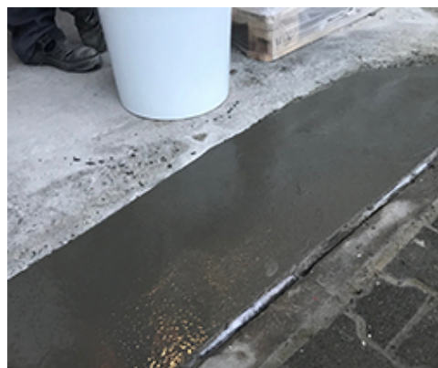
Mapegrout SV Smart wygładzony pacą
