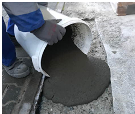
Wylanie Mapegrout SV Smart na podłoże betonowe
