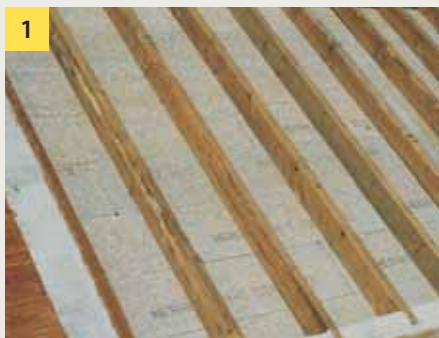
Połąć dachowa z widocznymi krokiewiami.
