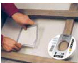
Trwałe klejenie zakładów.
