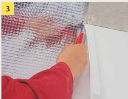
3 Przyciąć DELTA ® -REFLEX na łączeniu krokwi/komina z betonowym wieńcem.
