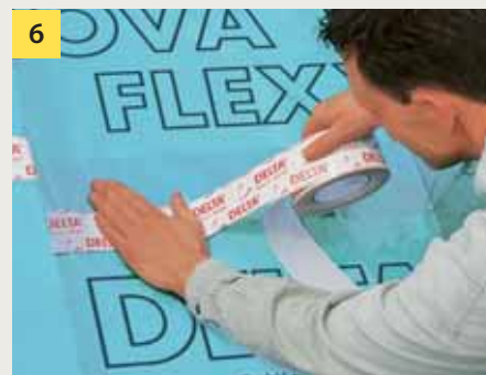
Zakłady skleić należy szczelnie przy pomocy DELTA®-MULTI-BAND.
