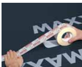
Do zakładów, przebić oraz do naprawy pęknięć.
