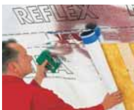
Sprawdzona wiatro i paroizolacja.
