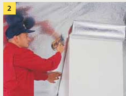
2 Odpowiednio przyciąć DELTA ® -REFLEX za pomocą zszywek przymocować do krokwi.
