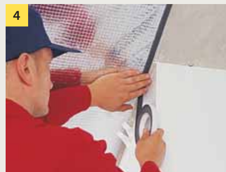
4 Przykleić DELTA ® -KOM-BAND wokół betonowego wieńca.
