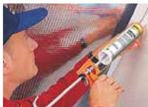
Klej z kartuszy do wiatroszczelne- go przyłączania do muru. Zast. wew.
