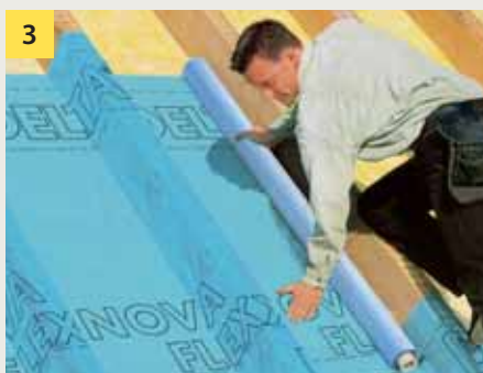
DELTA®-NOVAFLEXX/DELTA®-S d -FLEXX układana jest na krokwiach.
