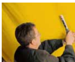
Nie wzmocniona polietylenowa folia wiatro i paroizolacyjna.
