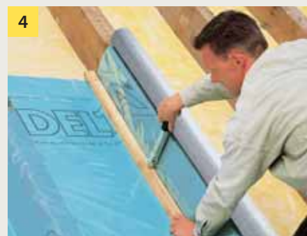
Podczas przeciągania folii ponad krokiewiami zaleca się używać łat pomocniczych.
