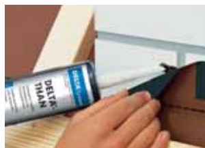
Trwale elastyczny klej ze specjali- stycznego kauczuku. Zast. zew.
