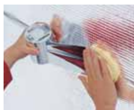
Do wierzchniego sklejenia miejsc zakładów.
