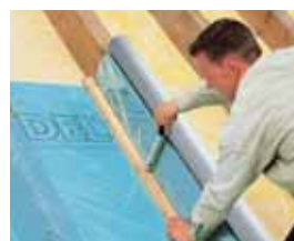
Opóźniacz przepływu pary wodnej o zmiennej wartości S_d do remontów i przekładek dachów.
