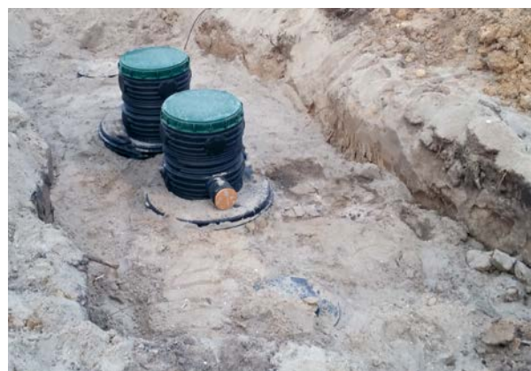
Rysunek 2. Oczyszczalnia actibio podczas montażu.
