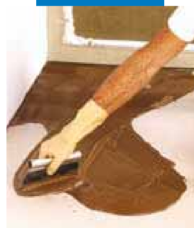
Rozprowadzanie kleju na podłożu
