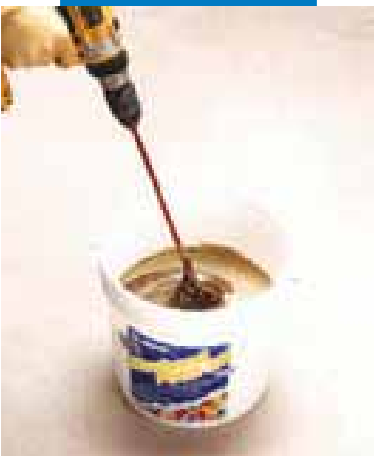
Mieszanie kleju dwuskładnikowego Adesilex G19
