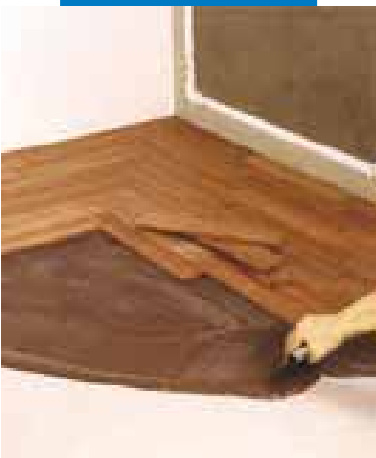
Rozprowadzenie kleju Adesilex G19 przy użyciu szpachli zębatej
