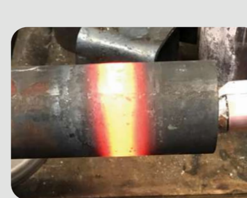
Konserwacja kotła gazowego : - Induktor Heat Tube S180/D50 - Powerduction 160LG
