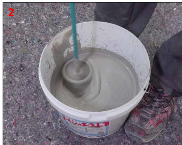
Sopro FDK 415: składnik płynny B wlać do czystego pojemnika i przy pomocy mieszarki wymieszać ze składnikiem proszkowym A, aż powstanie jednolita, bez grudek, masa.
