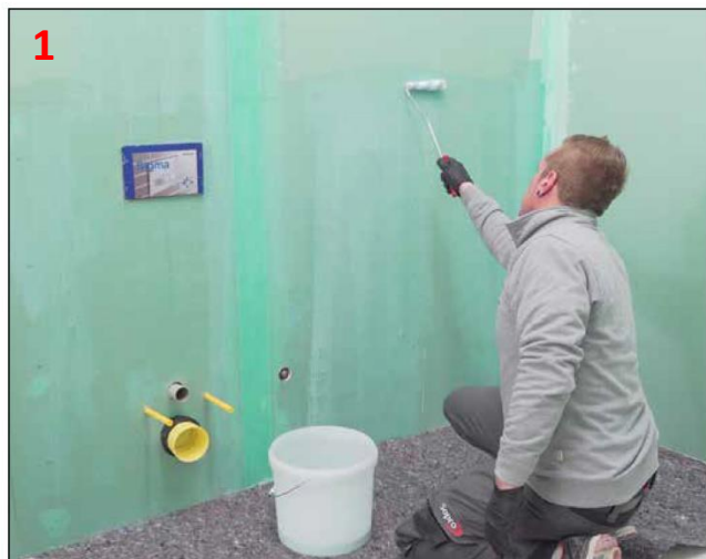
Podłoże chłonne zagruntować preparatem Sopro GD 749.
