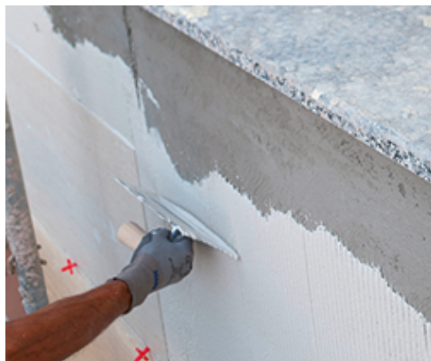
Rozprowadzanie kleju na podłożu, montaż na elewacji
