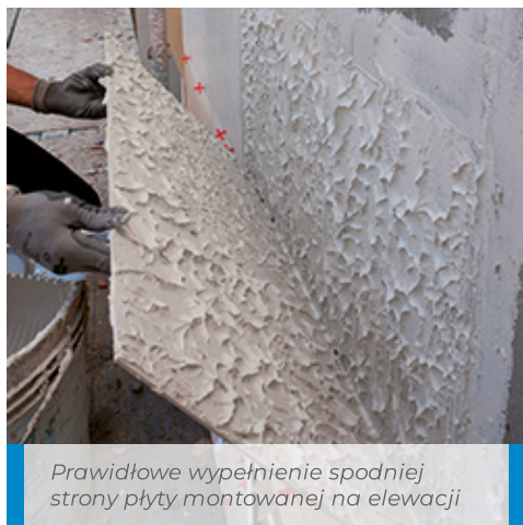
Rozprowadzanie kleju na podłożu, montaż na elewacji
