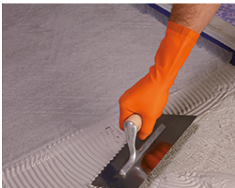
Nakładanie pierwszej warstwy Monolastic na Mapetex Sel na nowym jastrychu
