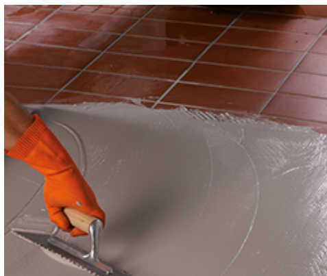
Nakładanie drugiej warstwy Monolastic na Mapenet 150
