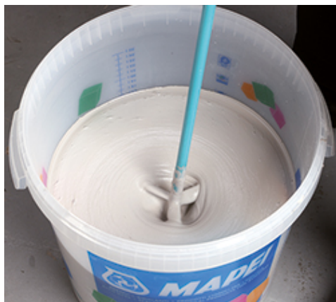
Mieszanie zaprawy Monolastic
