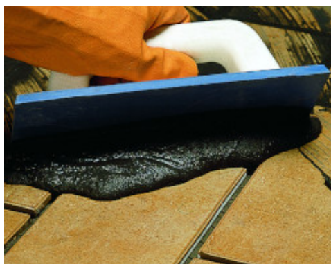
Spoinowanie zewnętrznej posadzki z klinkieru z użyciem Keracolor GG zmieszanim z Fugolastic
