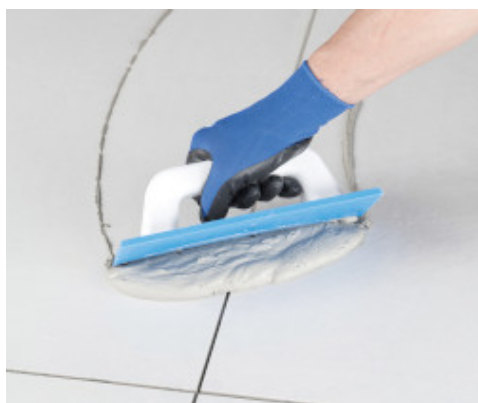
Spoinowanie płytek przy pomocy pacy gumowej
