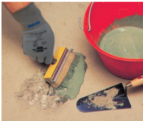
Naprawa podłoża: wykonywanie warstwy szczepnej
