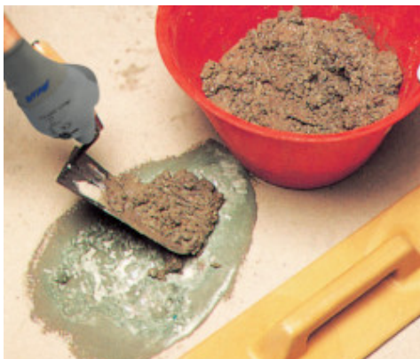
Naprawa podłoża: aplikacja zaprawy naprawczej
