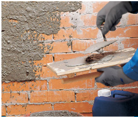
Narzucanie zaprawy z dodatkiem Planicrete
