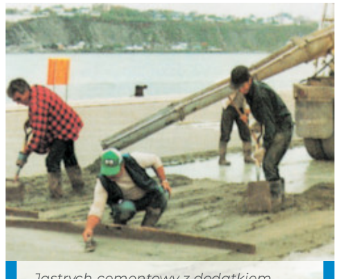
Jastrych cementowy z dodatkiem Planicrete, wykonywany na zewnątrz. Vieux Port, Quebec, Kanada
