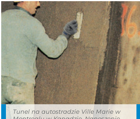
Naprawa podłoża: aplikacja zaprawy naprawczej
