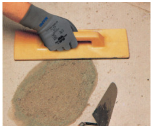
Naprawa podłoża: końcowe wygładzanie powierzchni
