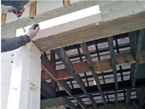
Zdjęcie nr 15 – Montaż górnej linii CBM
