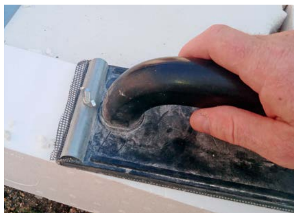
Zdjęcie nr 6 – Równanie i poziomicowanie płaszczyzny styropianowej pod belki podprogowe przy użyciu „tarki do styropianów” lub innych szlifujących narzędzi
