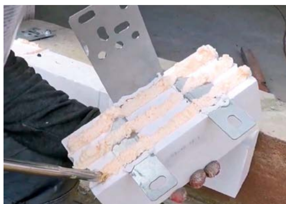
Zdjęcie nr 12 – Nałożenie kleju do styropianu PU
