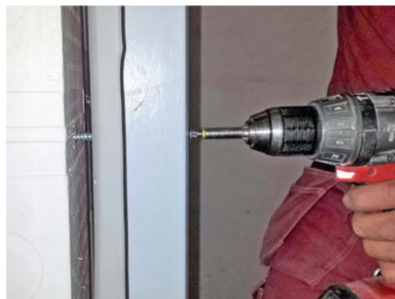
Zdjęcie nr 27 – Wkręcanie śrub ościeżnicowych
