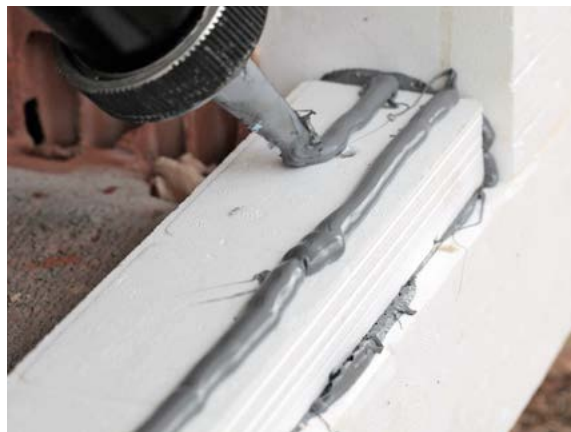
Zdjęcie nr 23 – Nakładanie hybrydy na belkę BP przygotowanie do połączenia belki BP z futryną
