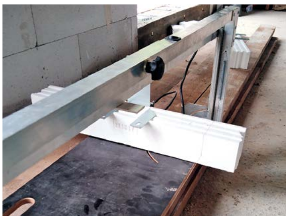
Zdjęcie nr 7 – Docinanie belek CBM struną termiczną
