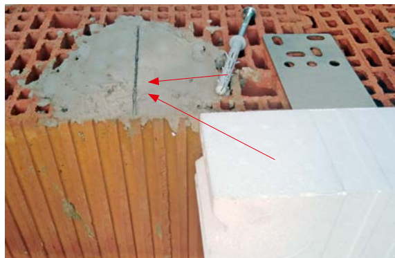
Zdjęcie nr 4 – Wzmocnienie nośności podłoża w miejscu montażu blach wsporników CBM poprzez zalanie pustaków ceramicznych zaprawą
