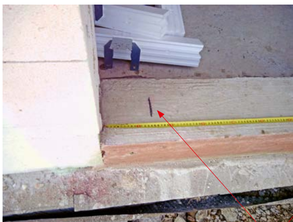
Zdjęcie nr 1 – Pomiar kontrolny otworu, naniesienie osi belek CBM
