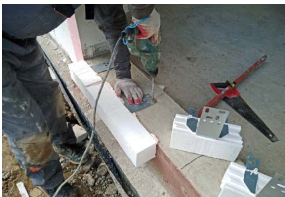
Zdjęcie nr 13 – Montaż dolnej linii CBM
