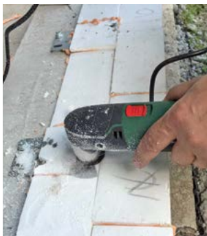
Zdjęcie nr 19 – Szlifowanie za pomocą szlifierki oscylacyjnej
