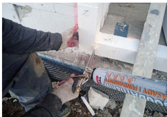
Zdjęcie nr 14 – Montaż bocznej linii CBM
