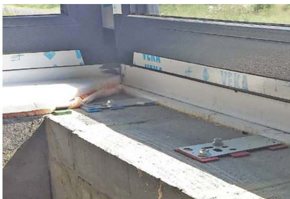
Zdjęcie nr 28 – Montaż parapetów wewnętrznych (PPW)
