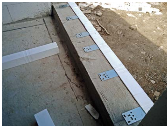
Zdjęcie nr 10 – Próbné ustawienie dociętych belek
