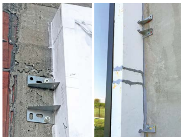
Zdjęcia nr 31; 32 – Szpachlowanie spoin i składeń belek CBM uszczelniaчем hybrydowym w miejscach gdzie możliwe jest gromadzenie się wody oraz akrylem na łączeniach pozbawionych takiego ryzyka (np. sputkanie deszczem w trakcie wiązania)
