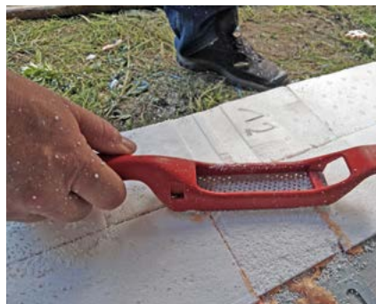
Zdjęcie nr 20 – Szlifowanie za pomocą tarki do styropianu
