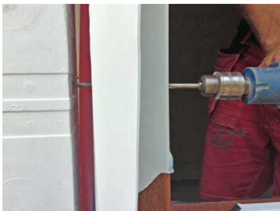
Zdjęcie nr 26 – Wiercenie otworów w wspornikach
