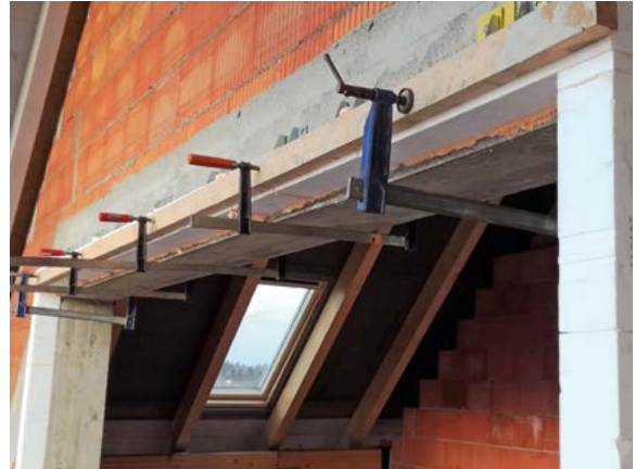
Zdjęcie nr 16 – Użycie ścisków ułatwia i przyspiesza prace
