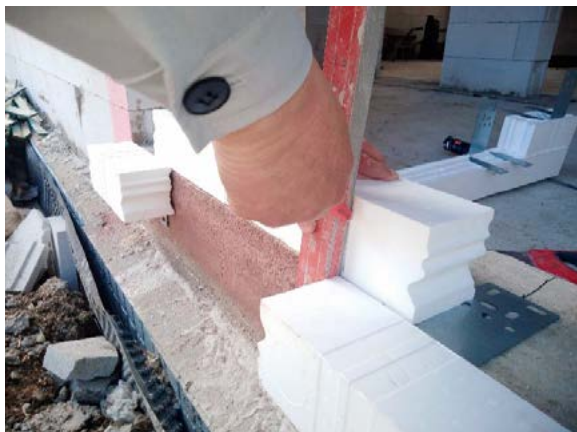
Zdjęcie nr 9 – Domierzanie belek „w naturze”
