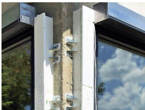
Zdjęcie nr 30 – Zamontowany Węgarek (W)
