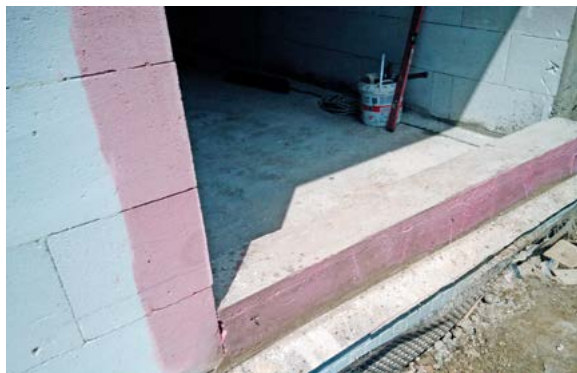
Zdjęcie nr 3 – Przygotowanie otworu – gruntowanie
