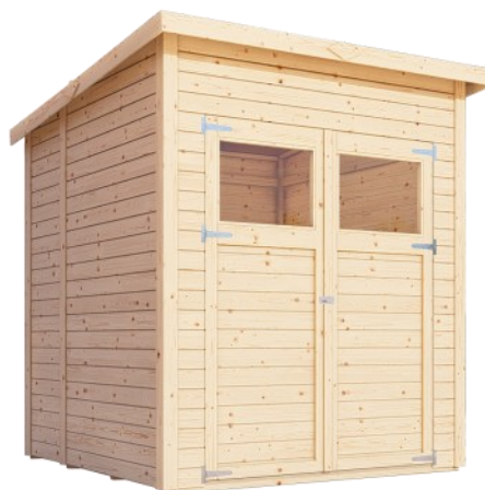
Budynek nie pomalowany.
