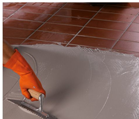
Nakładanie drugiej warstwy Monolastic na Mapenet 150
