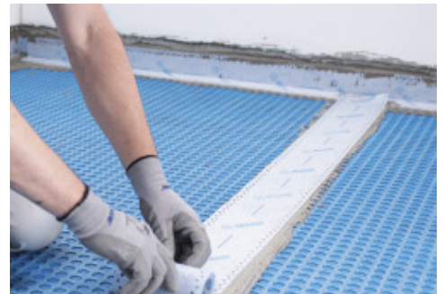
Uszczelnianie łączeń między arkuszami membrany taśmą Mapeband W lub Mapeband Easy, przyklejoną klejem Mapeguard WP Adhesive
