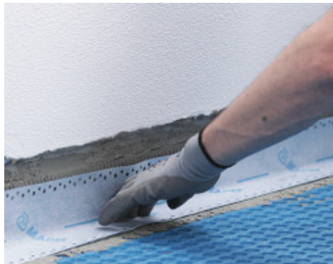
Przyklejanie taśmy Mapeband W lub Mapeband Easy klejem Mapeguard WP Adhesive na styku ściana-podłoga
