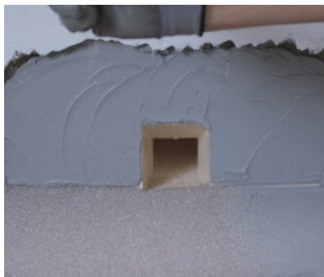
Uszczelnianie odpływu z użyciem profilu Drain Front
