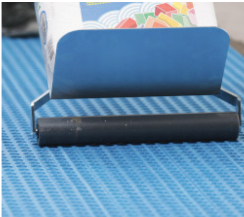
Dociskanie membrany do podłoża
