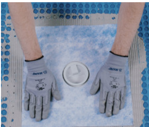
Uszczelnianie odpływu przy użyciu profili Drain Vertical/Drain Lateral
