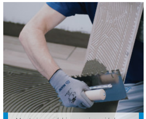
Montaż posadzki ceramicznej lub kamiennej z użyciem odpowiedniego kleju MAPEI klasy co najmniej C2S1
