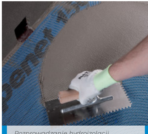
Rozprowadzanie hydroizolacji Mapelastyc na siatce Mapenet 150
