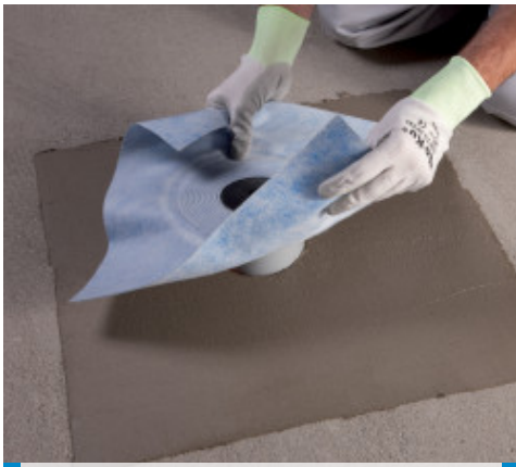
Montaż Drain Vertical na Mapelastyc
