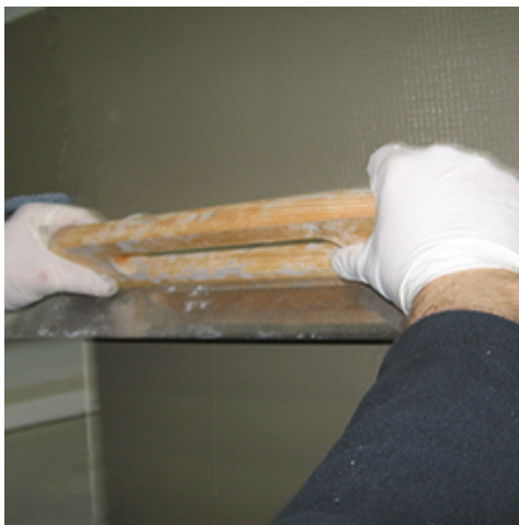
Wyrównywanie warstwy zaprawy Mapetherm do siatki z zatopioną siatką z włókna szklanego
