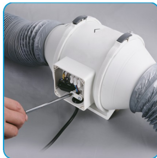
6. Wykonaj podłączenia elektryczne
