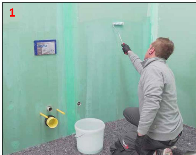
Podłoże chłonne zagruntować preparatem Sopro GD 749.
