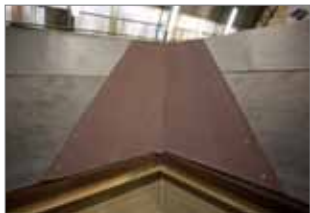
Zamontowana papa koszowa.
