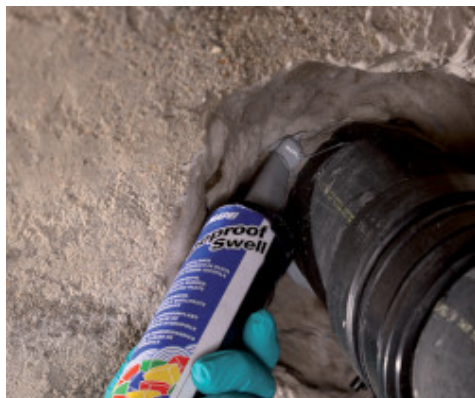
Element przechodzący uszczelniony Mapeproof Swell
