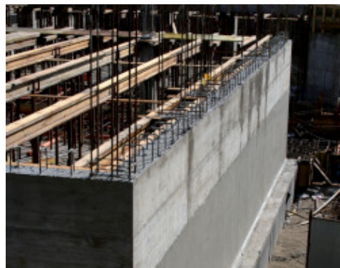
Uszczelnienie muru oporowego przy użyciu Mapelastik Foundation po wlaniu w formę
