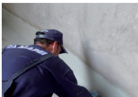
Rozprowadzanie Mapelastik Foundation szpachelką przy wykonywaniu hydroizolacji powierzchni poddawanej negatywnemu parciu wody
