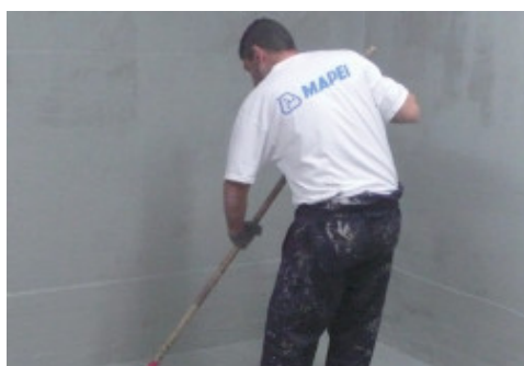
Rozprowadzanie warstwy Mapelastik Foundation wałkiem przy wykonywaniu hydroizolacji powierzchni poddawanej negatywnemu parciu wody
