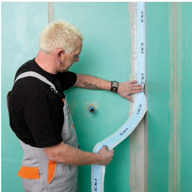
Wklejenie taśm PCI Pecitape®. Obiekt na warstwie izolacji PCI Lastogum® szary.
