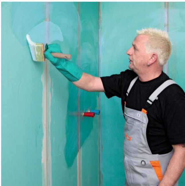
Gruntowanie nierozcieńczonym środkiem PCI Gisogrund®.
