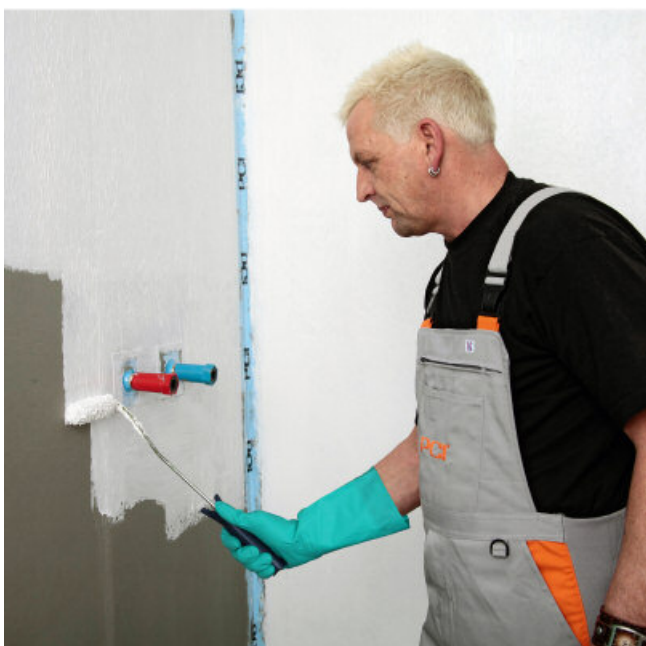
Wykonanie (z pełnym pokryciem podłoża) na całej powierzchni warstwy izolacji PCI Lastogum® biały.
