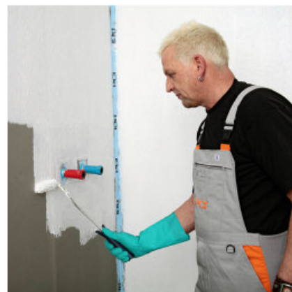
PCI Lastogum ® należy aplikować bez rozcieńczania wałkiem pędzlem lub przez szpachlowanie.
