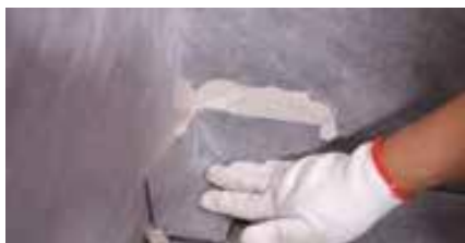
Installera vattentäta hörnen (medföljer ej)
