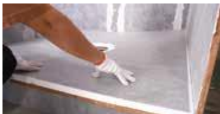
Bädda in brickan i murbruket
