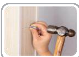
14. Insert the expansion screw nei buchi.
