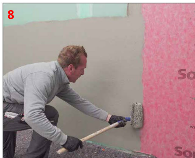
Wzdłuż brzegów maty Sopro AEB® 640, nanieść klej Sopro FDK 415 lub zaprawę uszczelniającą Sopro DSF RS 623 na szerokości ok. 5 cm.
