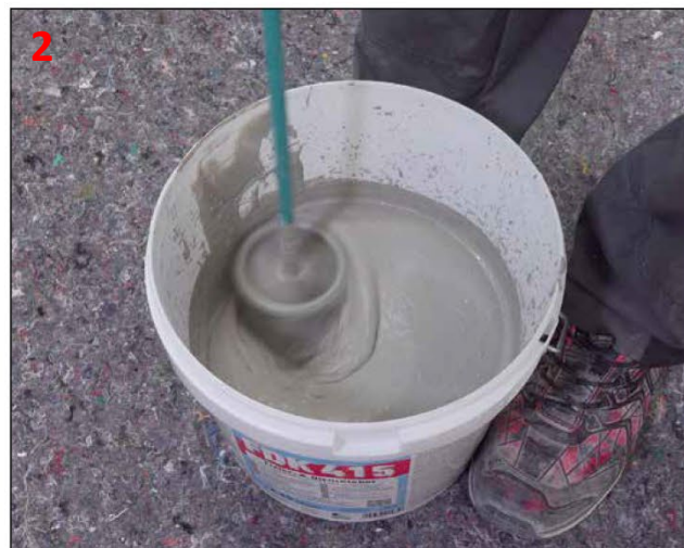
Sopro FDK 415: składnik płynny B wlać do czystego pojemnika i przy pomocy mieszarki wymieszać ze składnikiem proszkowym A, aż powstanie jednolita, bez grudek, masa. Alternatywnie: DSF RS 623 wymieszać z wodą w odpowiedniej proporcji.
