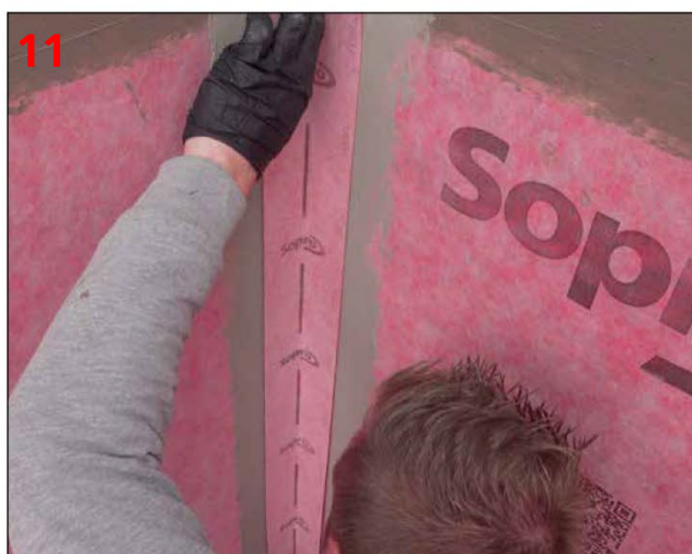
Odpowiednio przycięte odcinki taśmy uszczelniającej Sopro AEB® 148 przyłożyć do podłoża pokrytego świeżą warstwą kleju wodoszczelnego lub zaprawy uszczelniającej i mocno docisnąć.
