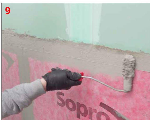
Krańcowe odcinki maty Sopro AEB® 640 obrobione również klejem wodoszczelnym Sopro FDK 415 lub zaprawą Sopro DSF RS 623.
