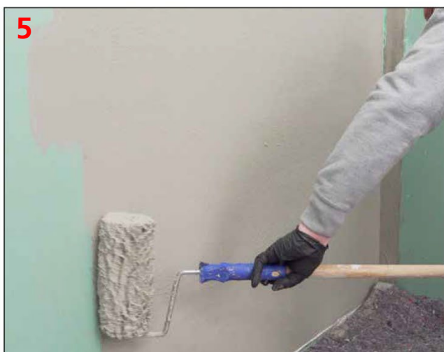
Zalecamy nakładanie kleju wodoszczelnego Sopro FDK 415 lub zaprawy Sopro DSF RS 623 w warstwie o równomiernej grubości na całej powierzchni.
