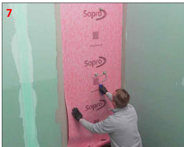
Przycięty na wymiar odcinek maty Sopro AEB® 640 przyłożyć do świeżej warstwy kleju rozprowadzonego na podłożu, mocno docisnąć matę od środka do kierunku krawędzi.
