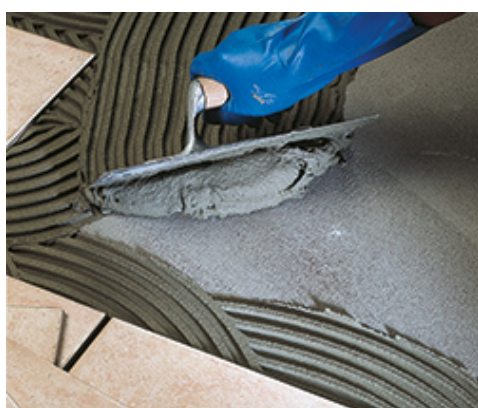
Montaż płytek typu monocottura na podłodze
